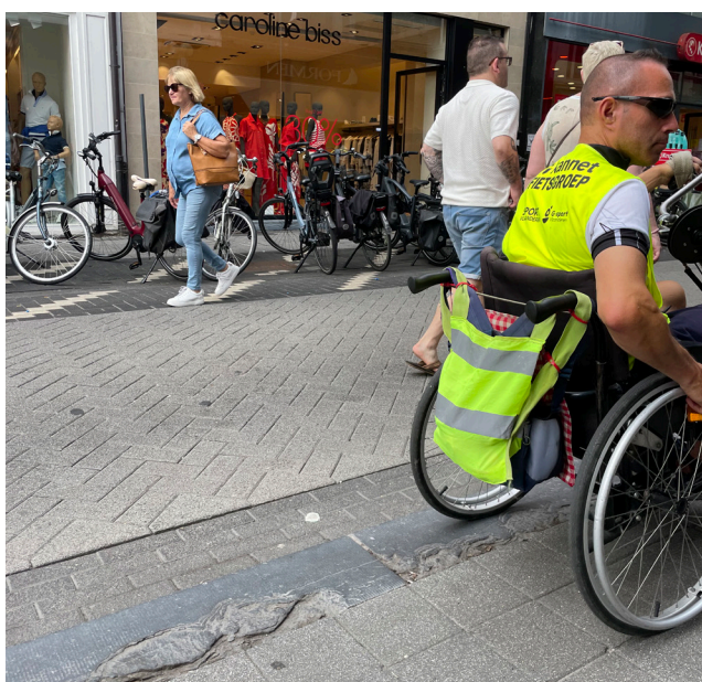
Door de vele oneffenheden moet je als rolstoelgebruiker slalommen door de straat. Gesloten boomroosters zorgen voor extra manoeuvreerruimte.
