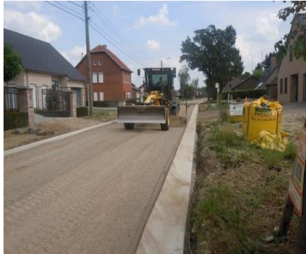
Figuur 3 - afwerken fundering
