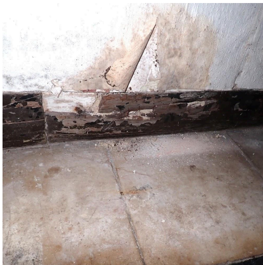
plint door houtzwam aangetast
