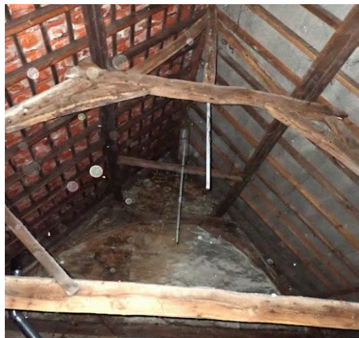
zolder [1]: vezelcement onderdak is asbesthoudend ... en beschadigd
