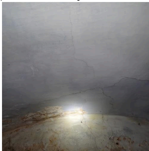
scheurvorming
