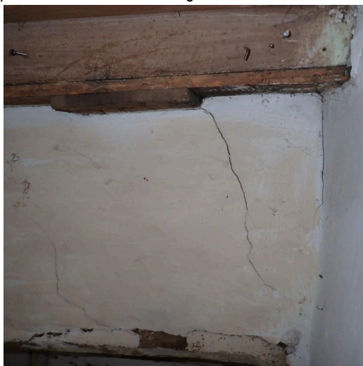
scheurvorming
