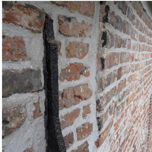
vleugel [1]: de verf verschrompelt met beginnende roestvorming
