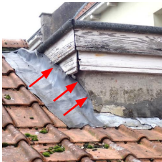
dak [3]: de loodslabben zijn koud opgetrokken en ...
