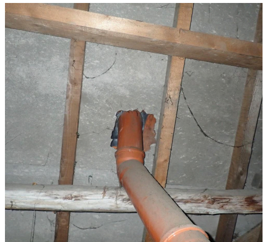
zolder [1]: vezelcement onderdak is asbesthoudend ... en beschadigd
