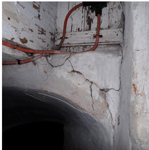
scheur in de aanzet van het gewelf
