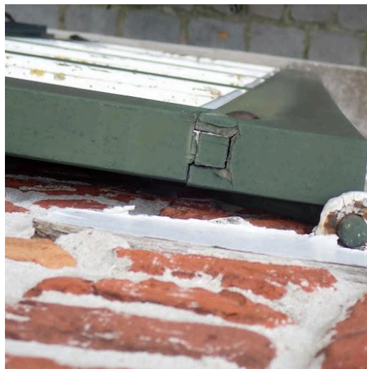
vleugel [1]: openstaande pen en gatverbinding
