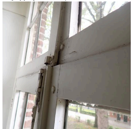
vleugel [1]: raam sluit niet af
