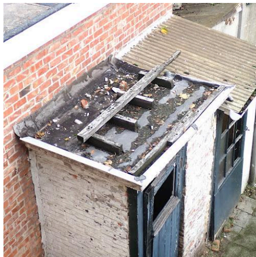
dak [5]: de balken houden het vuil vast
