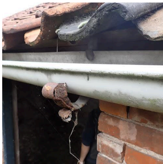
vleugel [4]: sterk verweerde PVC goot en sterk roestige beugel
