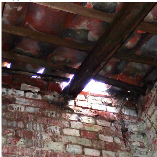
dak [4]: ingerotte dakstructuur
