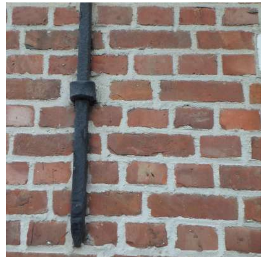
verf verschrompeld met beginnende roestvorming
