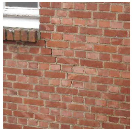
vleugel [2]: lichte zettingsscheur
