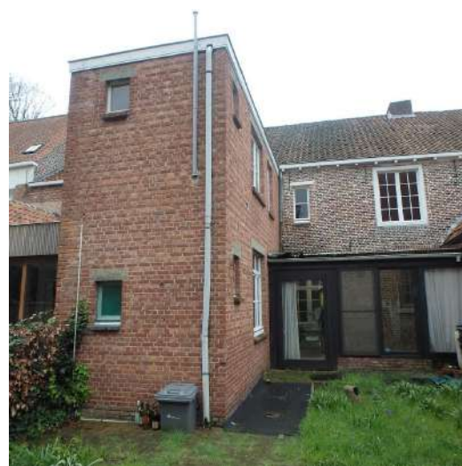
dak [1] enkel via dak [2] toegankelijk met een lange ladder die niet door de woning kan
