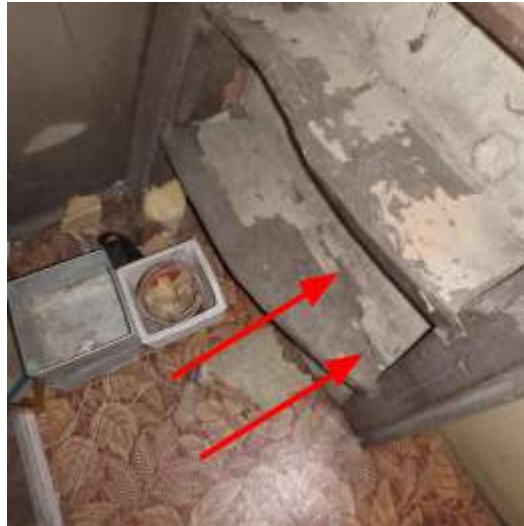
ingescheurde trede
