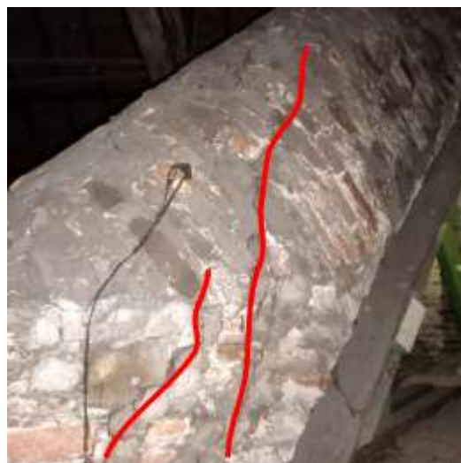
scheurvorming
