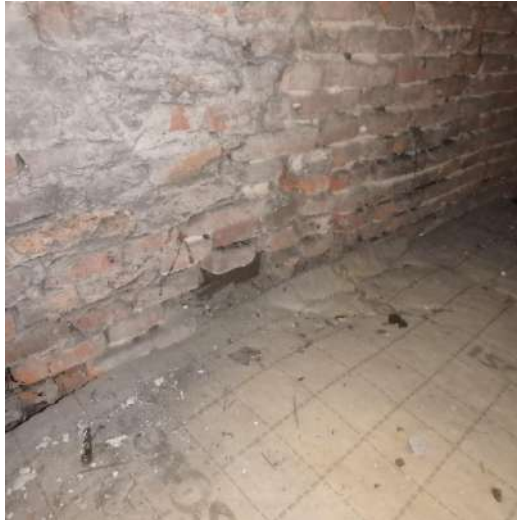
zoldervloer niet zichtbaar door de isolatie
