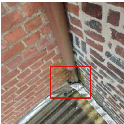
leke aansluiting met de afvoer
