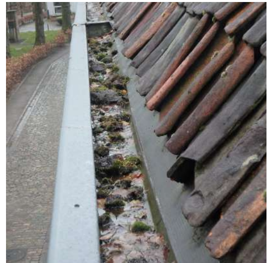
dak [1]-straatzijde: de goot is vervuild en...
