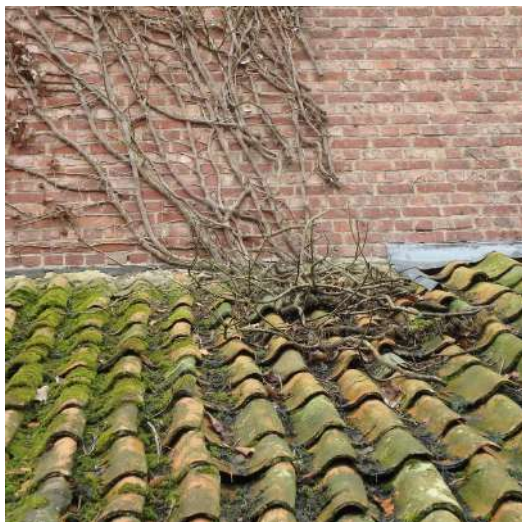
De afgezaagde resten drukken op dak [4]
