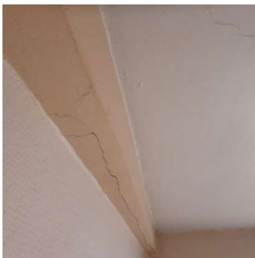
gescheurd pleisterwerk
