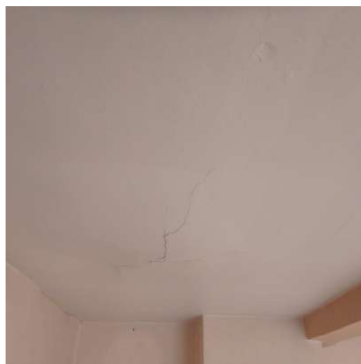
gescheurd pleisterwerk
