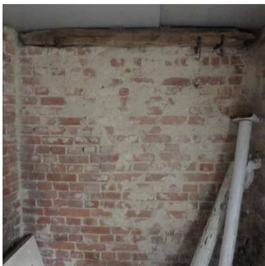
vleugel [4]-west: lichte zettingsscheur
