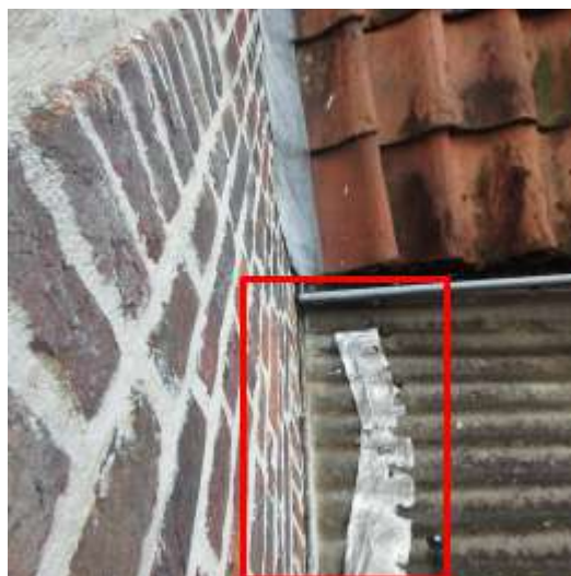
de bitumentape aansluiting valt weg
