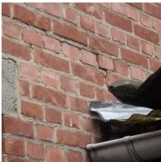
vleugel [2]: lichte zettingsscheur
