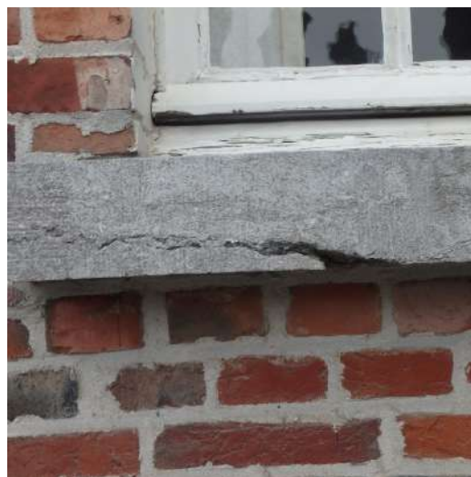
uitgespoelde koolstofader en afgebroken stuk
