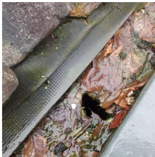
... het tapgat slibt dicht
