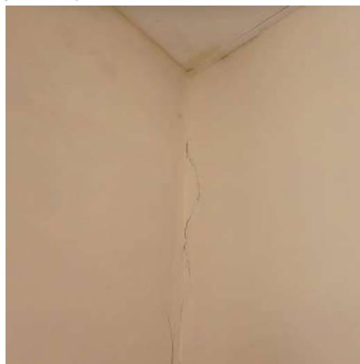
gescheurd pleisterwerk
