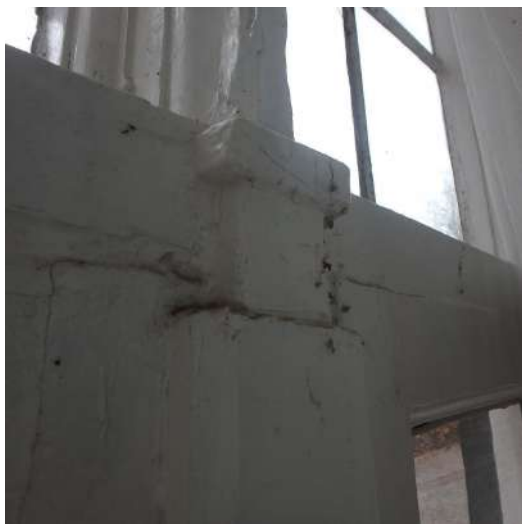
dichtgeschilderd sluitsysteem
