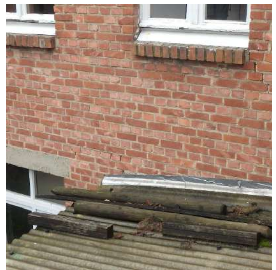
het dak wordt verstevigd met balken
