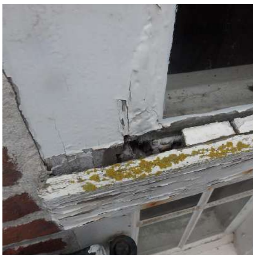
ingerotte verbinding en voorzetregel
