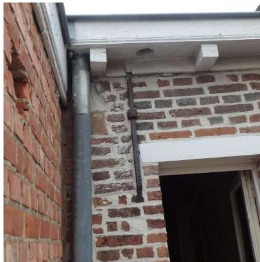
verf verschrompeld met beginnende roestvorming
