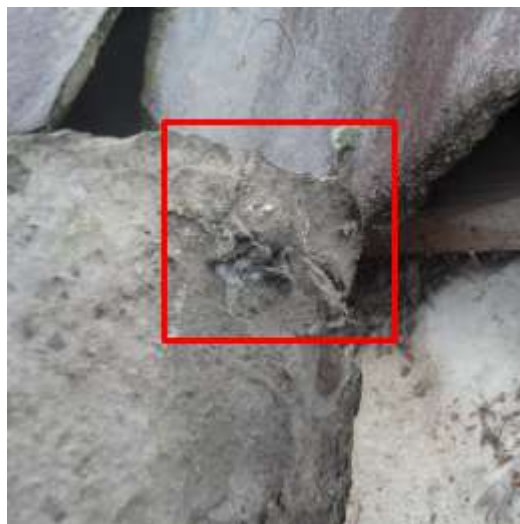
dak [1]: afgebroken neus
