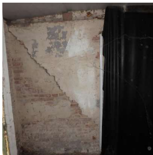
vleugel [4]-oost: grote zettingsscheur
