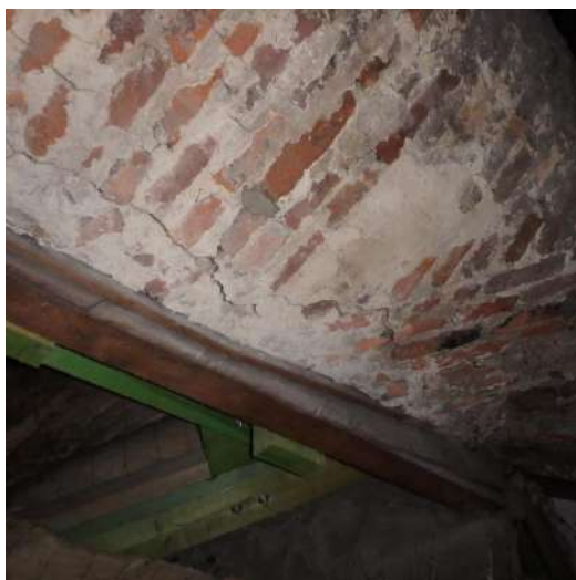
scheurvorming
