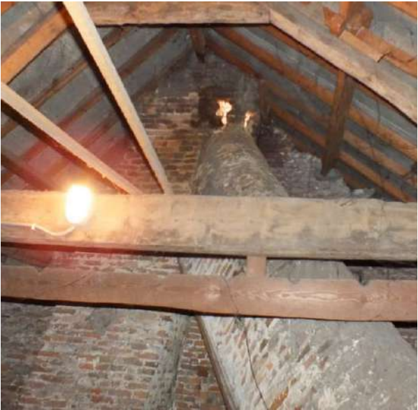
afb. 36: Zolder, schuin gemetselde schoorsteenkanaal.
