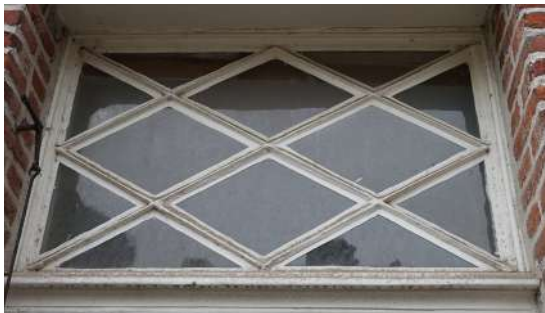
afb. 43: Voorgevel: detail inkomdeur en bovenlicht.
