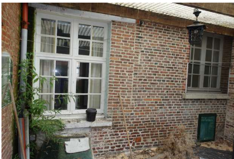
afb. 47: Woning nr. 20: achtergevel begane grond, toestand 2024.
