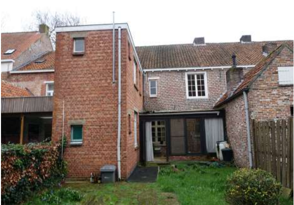
afb. 31: Gezicht op achtergevel met verbouwde aanbouw en veranda, huidige toestand 2024.
