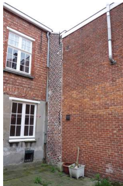
afb. 51: Aanbouw, zijgevel aan kant van woning nr. 21.
