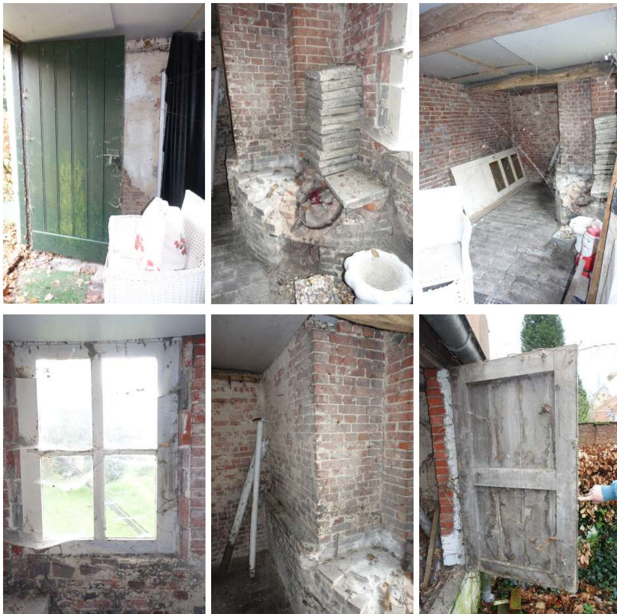
afb. 59: Woning nr. 20: tuinberging: interieur © ARAT architecten, huidige toestand 2024.
