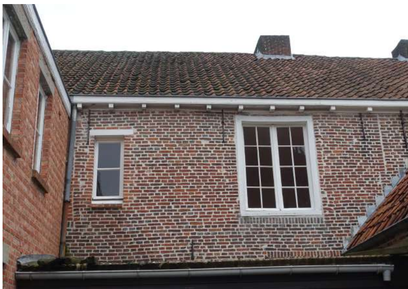
afb. 46: Woning nr. 20: achtergevel verdieping, toestand 2024.
