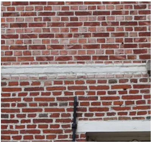
Detail met verschil van metselwerk tussen boven- en onderverdieping.
