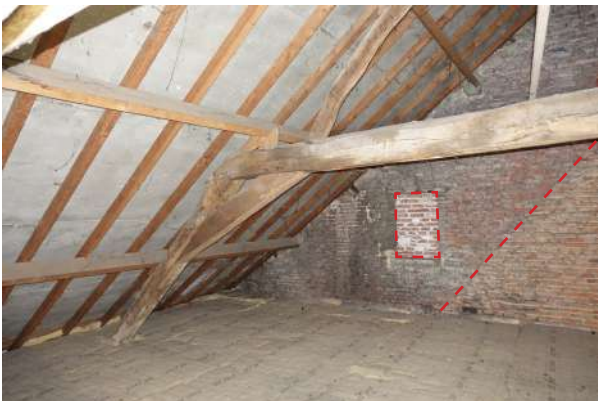
Bouwspoor van gedicht venster na uitbreiding.
