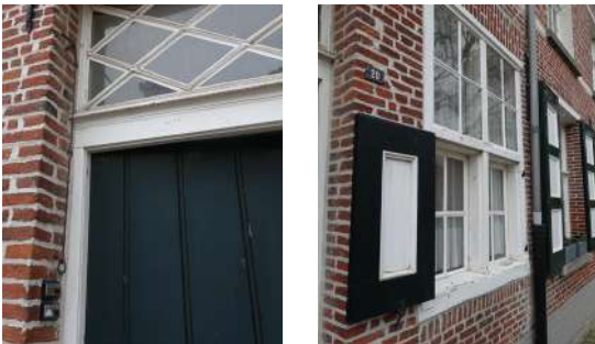
afb. 44: Voorgevel: detail trekbel en venster.
