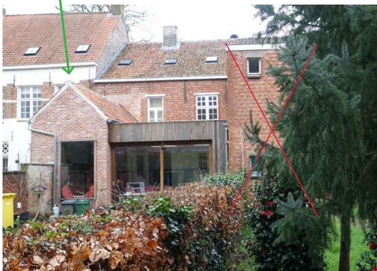
afb. 53: Foto uit 2024 met verbouwde aanbouw achter woning nr. 21.
