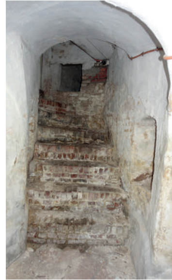
afb. 39: Nieuwe betonnen gewelfsels.
