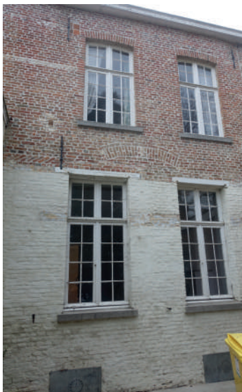
afb. 63: Kelderopening en restanten luikbeslag achtergevel: huidige toestand maart 2022.
