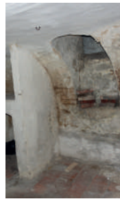
afb. 38: Bakstenen spiltrap.
