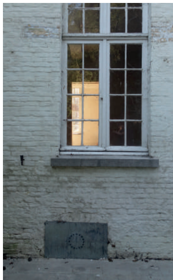
afb. 63: Kelderopening en restanten luikbeslag achtergevel: huidige toestand maart 2022.
