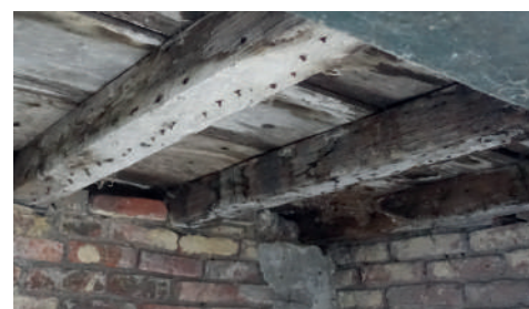
afb. 65: Kelderpeingen en restanten luikbeslag achtergevel: huidige toestand maart 2022.
