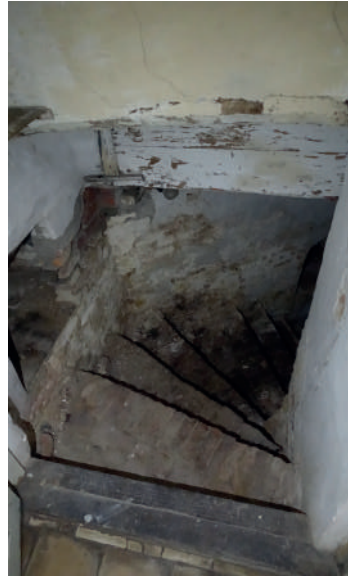
afb. 38: Bakstenen spiltrap.
