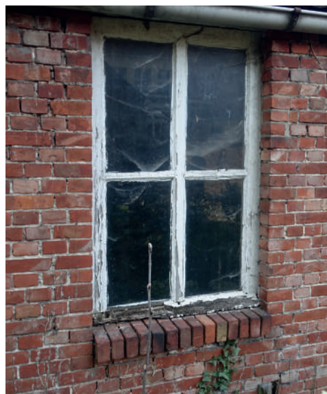
afb. 65: Kelderpeingen en restanten luikbeslag achtergevel: huidige toestand maart 2022.
