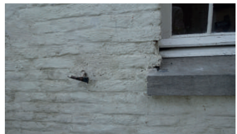
afb. 63: Kelderopening en restanten luikbeslag achtergevel: huidige toestand maart 2022.
