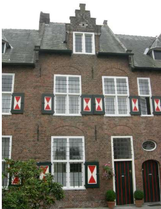
Afbeelding 11: Overzicht van de voorgevel
