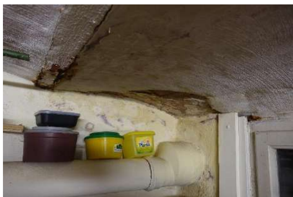
Afbeelding 74: roest aan de andere zijde van de kelder, waar ooit een huiszwam zat
