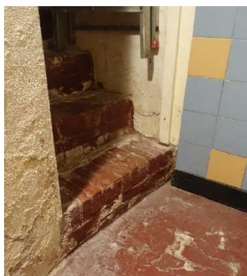
Afbeelding 44: zicht op de vloer, trap en betegeling
