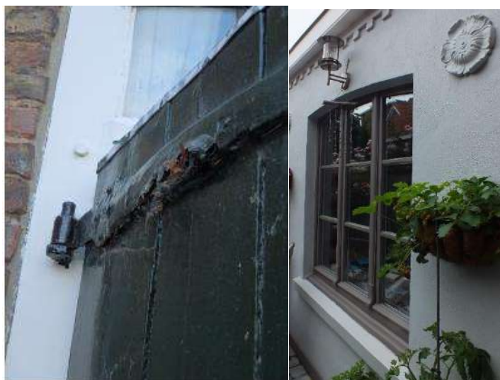
Afbeelding 65: Roestig hengsel
