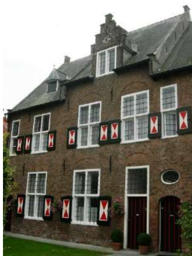
Afbeelding 54: overzicht van de voorgevel
