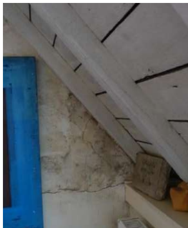
Afbeelding 76: Verregaande aantasting op de linker scheimuur
