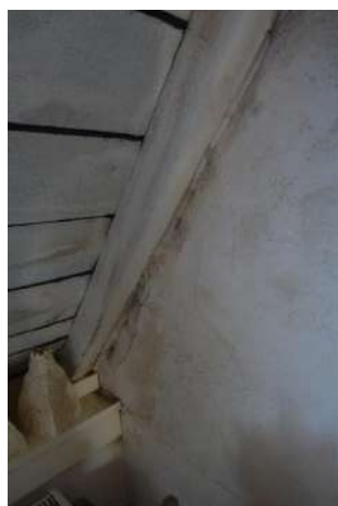
Afbeelding 75: Schimmel op de rechter scheimuur
