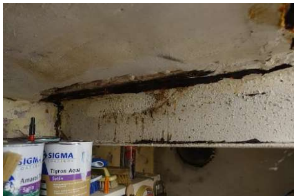
Afbeelding 72: roest aan een vrijliggend I-profiel
