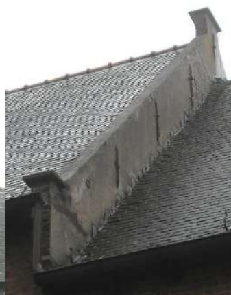
Afbeelding 17: Detail van de verhoogde scheidingmuur
