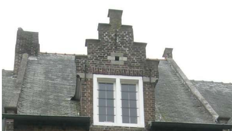
Afbeelding 16: Detail van het dak
