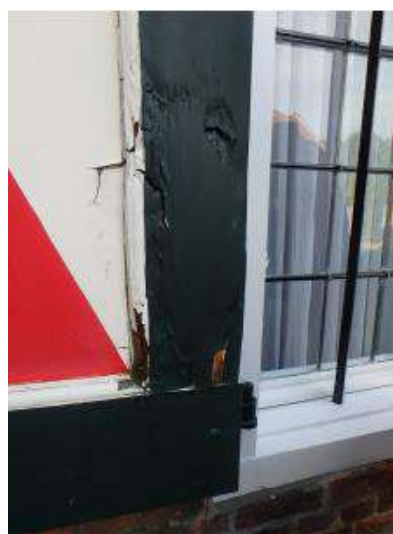
Afbeelding 64: Rotting aan het luik
