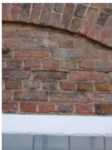
Afbeelding 56: Scheur boven het gelijkvloerse raam
