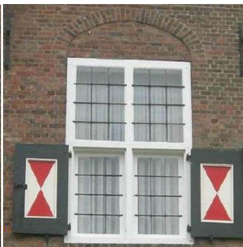
Afbelding 13: Raam op de verdieping
