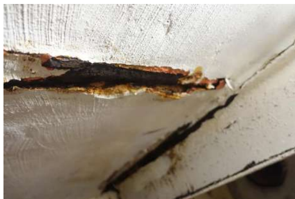
Afbeelding 73: Verregaande roest op een ligger tussen 2 gewelfjes
