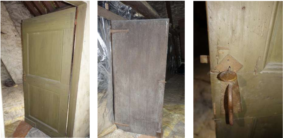
afb. 66: Schrijnwerk: zolderdeuren, huidige toestand 2024.
