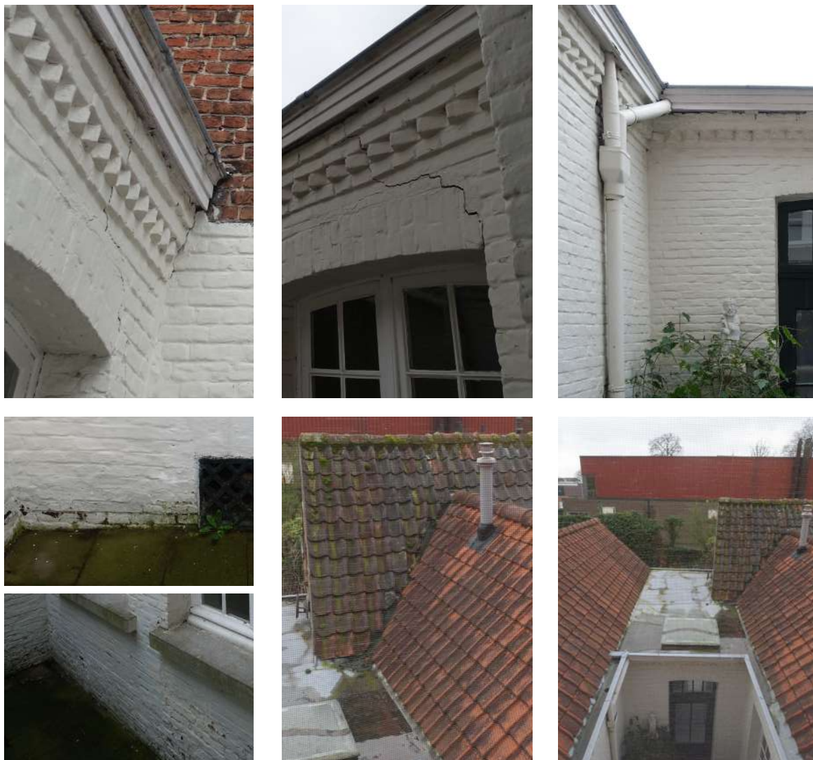
afb. 69: Details binnenkoergevels en bedaking aanbouwen, huidige toestand 2024.
