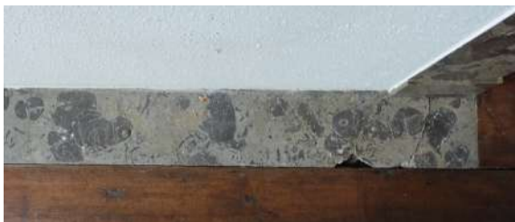
afb. 72: Detail houten deurdorpel en marmeren haardvloer, begane grond, huidige toestand 2024.
