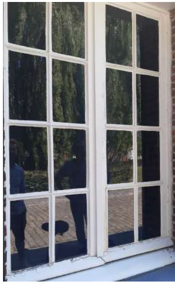
afb. 47: Woning nr. 31 na brand in 2023: bovenlicht deur, bewaard getrokken glas in venster begane grond en uitgebrand venster zolder © ARAT architecten, foto uit 2023.
