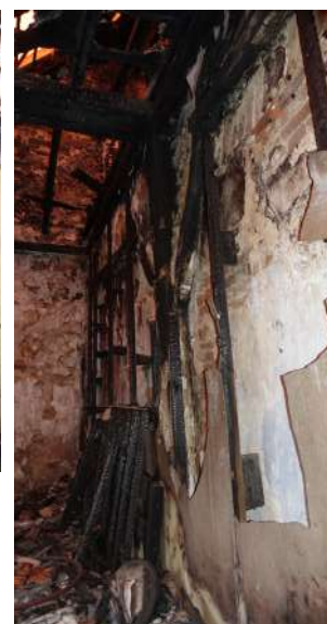
afb. 80: Opkamer, restant vakwerkgevel: toestand december 2023.
