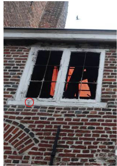
afb. 47: Woning nr. 31 na brand in 2023: bovenlicht deur, bewaard getrokken glas in venster begane grond en uitgebrand venster zolder © ARAT architecten, foto uit 2023.
