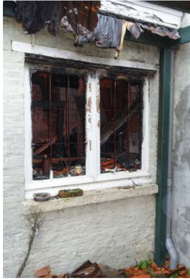
afb. 88: Schrijnwerk achtergevel: huidige toestand december 2023.
