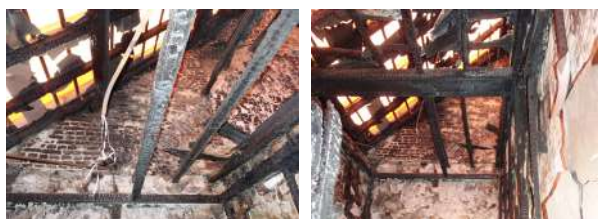
afb. 79: Opkamer, restanten zoldering: toestand december 2023.
