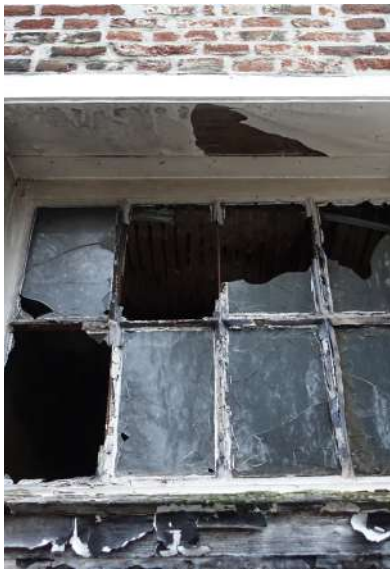
afb. 47: Woning nr. 31 na brand in 2023: bovenlicht deur, bewaard getrokken glas in venster begane grond en uitgebrand venster zolder © ARAT architecten, foto uit 2023.
