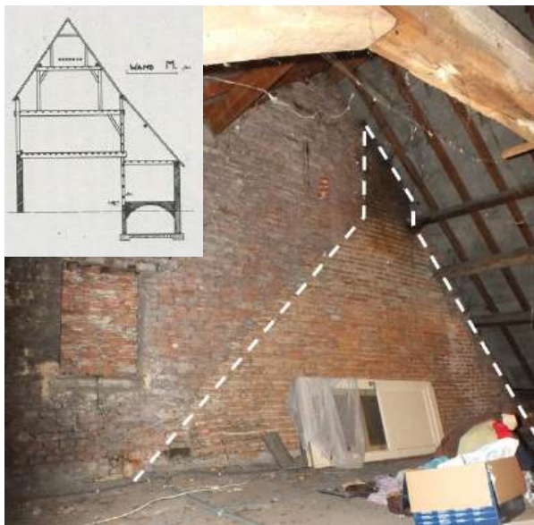
afb. 35: Zolder, scheidsmuur met bouwsporen van vroegere volume bedaking naar typologie van Kempisch woonhuis.
