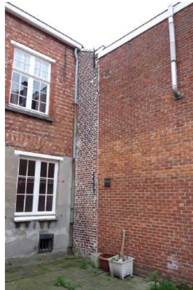
afb. 51: Aanbouw, zijgevel aan kant van woning nr. 21.
