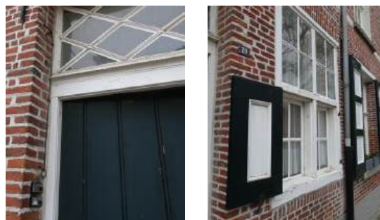
afb. 44: Voorgevel: detail trekbel en venster.
