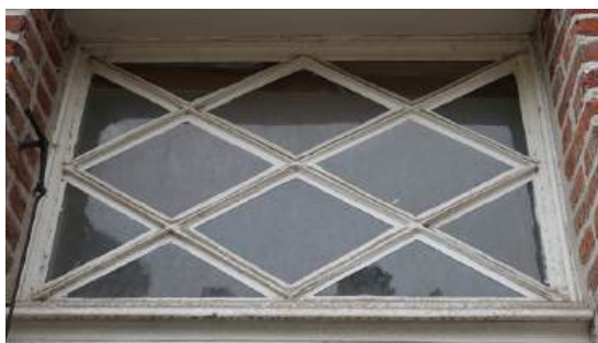
afb. 43: Voorgevel: detail inkomdeur en bovenlicht.
