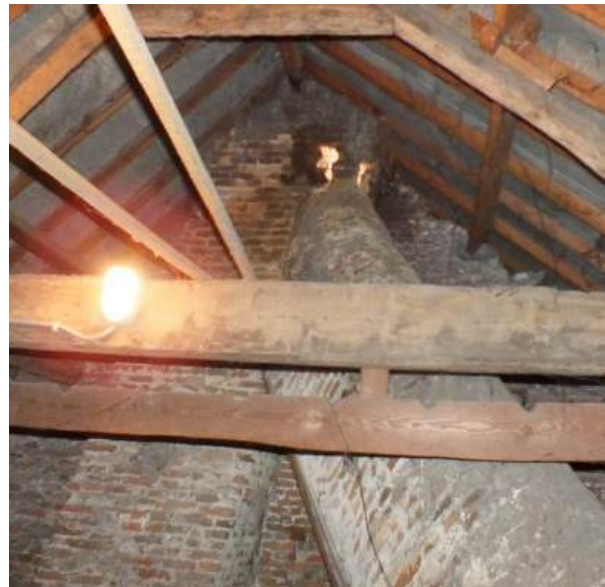
afb. 36: Zolder, schuin gemetselde schoorsteenkanaal.
