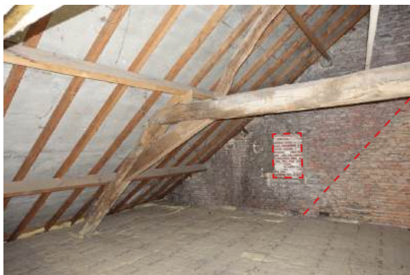
Bouwspoor van gedicht venster na uitbreiding.
