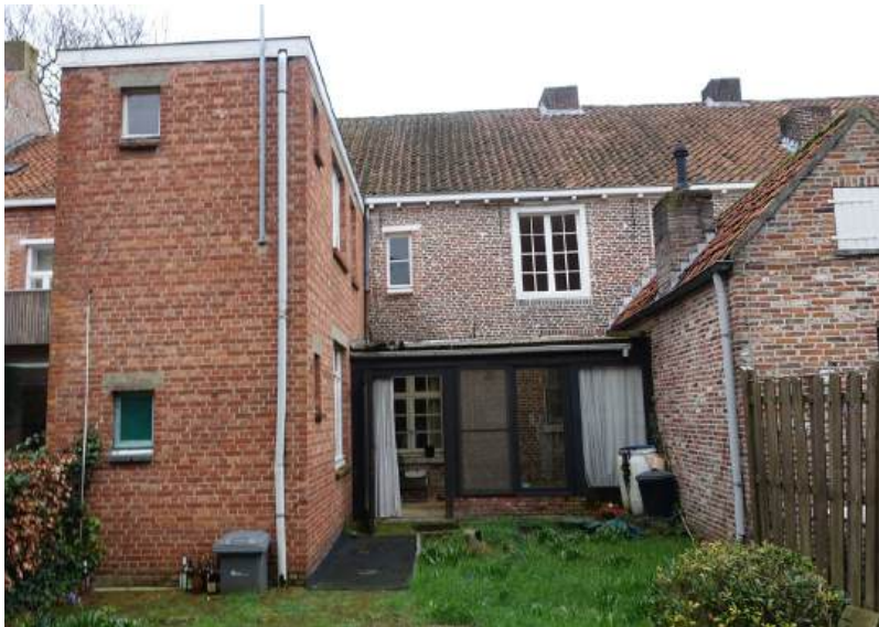
afb. 45: Woning nr. 20: achtergevel met aanbouw en veranda, huidige toestand 2024.
