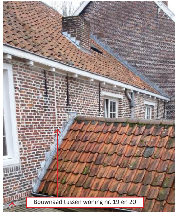
Bouwspoor van later opgehoogde verdieping
