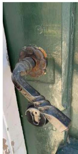
afb. 66: Verroeste onderdelen van ijzeren onderdelen: deurbeslag en voetschraper.
