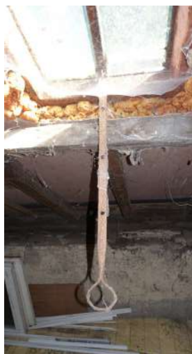
afb. 89: Erg roestig dakvlakvenster (zolder).
