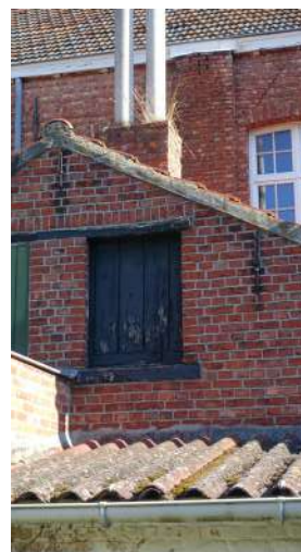
afb. 70: Voegwerk in cementmortel en verschaalde verflaag luik (aanbouw)
