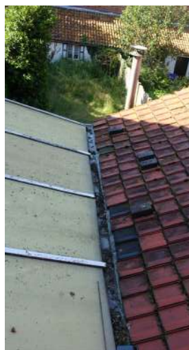
afb. 70: Voegwerk in cementmortel en verschaalde verflaag luik (aanbouw)
