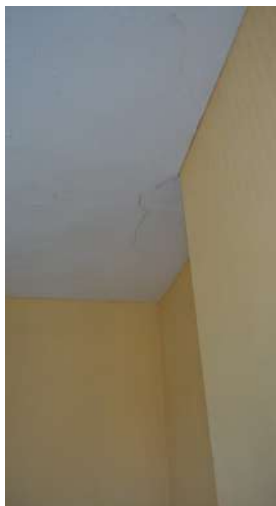
afb. 82: Scheuren in pleisterlagen (verdieping).
