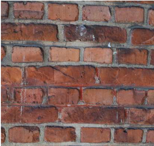
afb. 61: Gedegreerd rood voegwerk, voorgevel.
