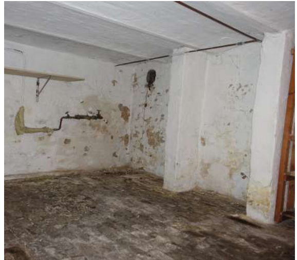
afb. 77: Kelder: vochtplekken, roestige ijzeren ligger en afschilferende pleisterlaag, huidige toestand 2024.
