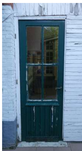
afb. 71: Verschaalde verflagen schrijnwerk.
