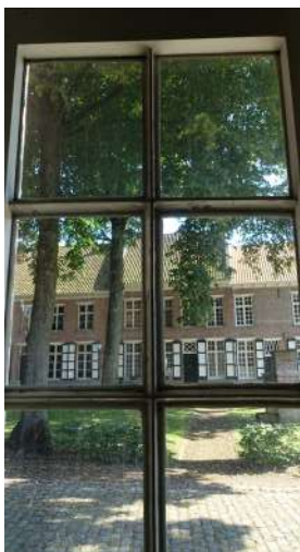
afb. 81: Authentiek 19de-eeuws venster met ijzeren glasroeden waarvan de witte verflaag afschilfert.
