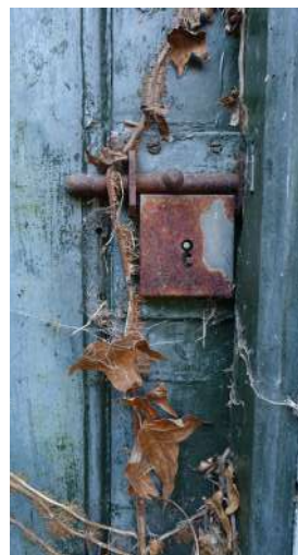
afb. 76: Verschaalde verflagen schrijnwerk en roestig deurbeslag (tuinberging).
