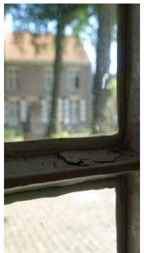
afb. 81: Authentiek 19de-eeuws venster met ijzeren glasroeden waarvan de witte verflaag afschilfert.
