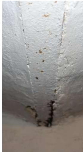
afb. 77: Kelder: vochtplekken, roestige ijzeren ligger en afschilferende pleisterlaag, huidige toestand 2024.
