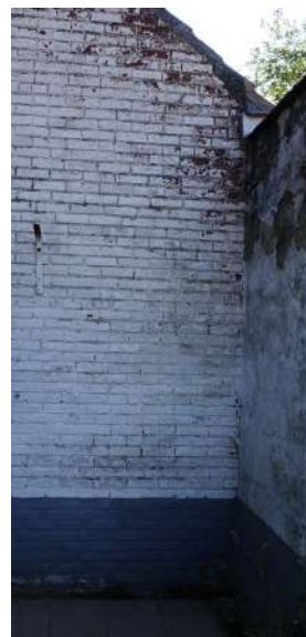
afb. 74: Verschaalde verflaag.
