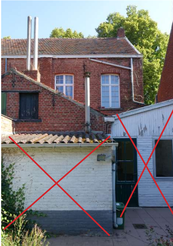
afb. 39: Storende aanbouwen (in rood aangegeven).
