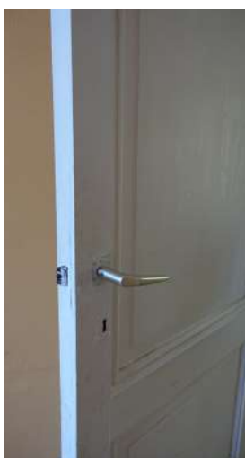
afb. 87: Modern deurbeslag en witte overschilderde afwerkingslagen (verdieping).
