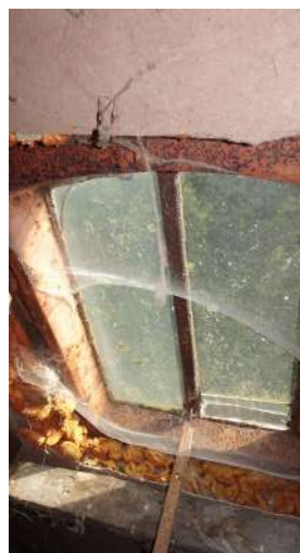
afb. 89: Erg roestig dakvlakvenster (zolder).
