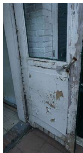
afb. 71: Verschaalde verflagen schrijnwerk.
