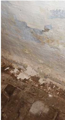
afb. 77: Kelder: vochtplekken, roestige ijzeren ligger en afschilferende pleisterlaag, huidige toestand 2024.
