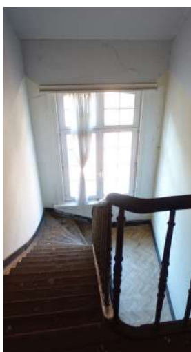
afb. 86: Scheur in pleisterwerk en linoleum vloerbekledingen (verdieping).
