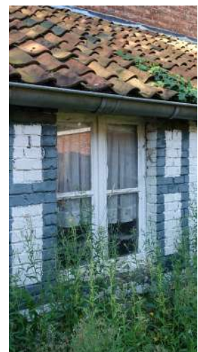
afb. 76: Verschaalde verflagen schrijnwerk en roestig deurbeslag (tuinberging).
