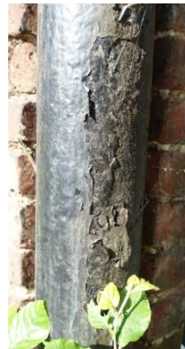
afb. 64: Verroeste onderdelen van ijzeren onderdelen: voetstuk regenafvoer en luikbeslag.
