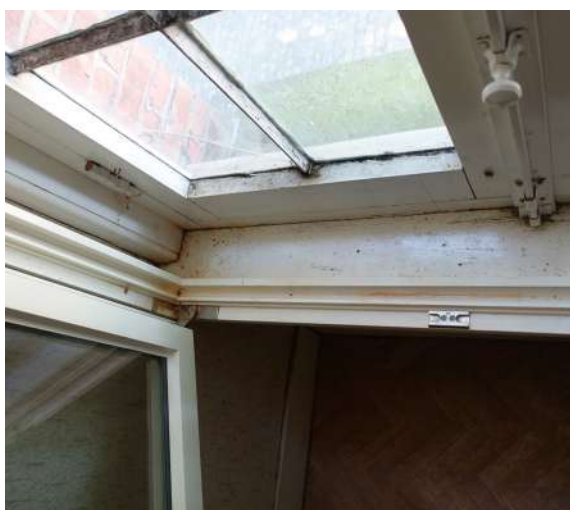
afb. 84: Gebarsten ruit (verdieping, voorgevel).
