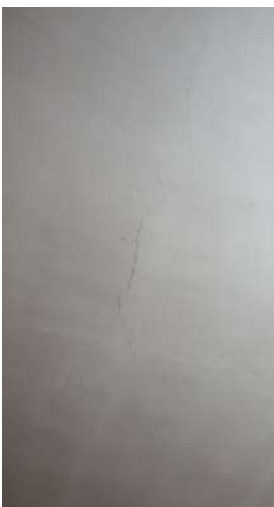
afb. 80: Scheuren en vochtplekken in pleisterlaag.
